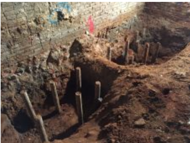
Foto 11. Excavació d'encepats
