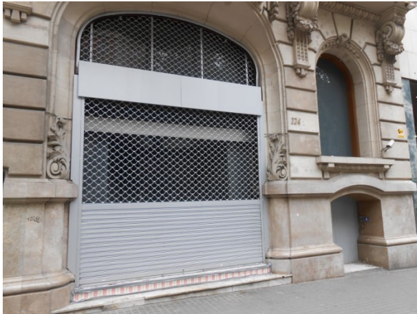
Foto 1. Façana principal. Entrada al soterrani
