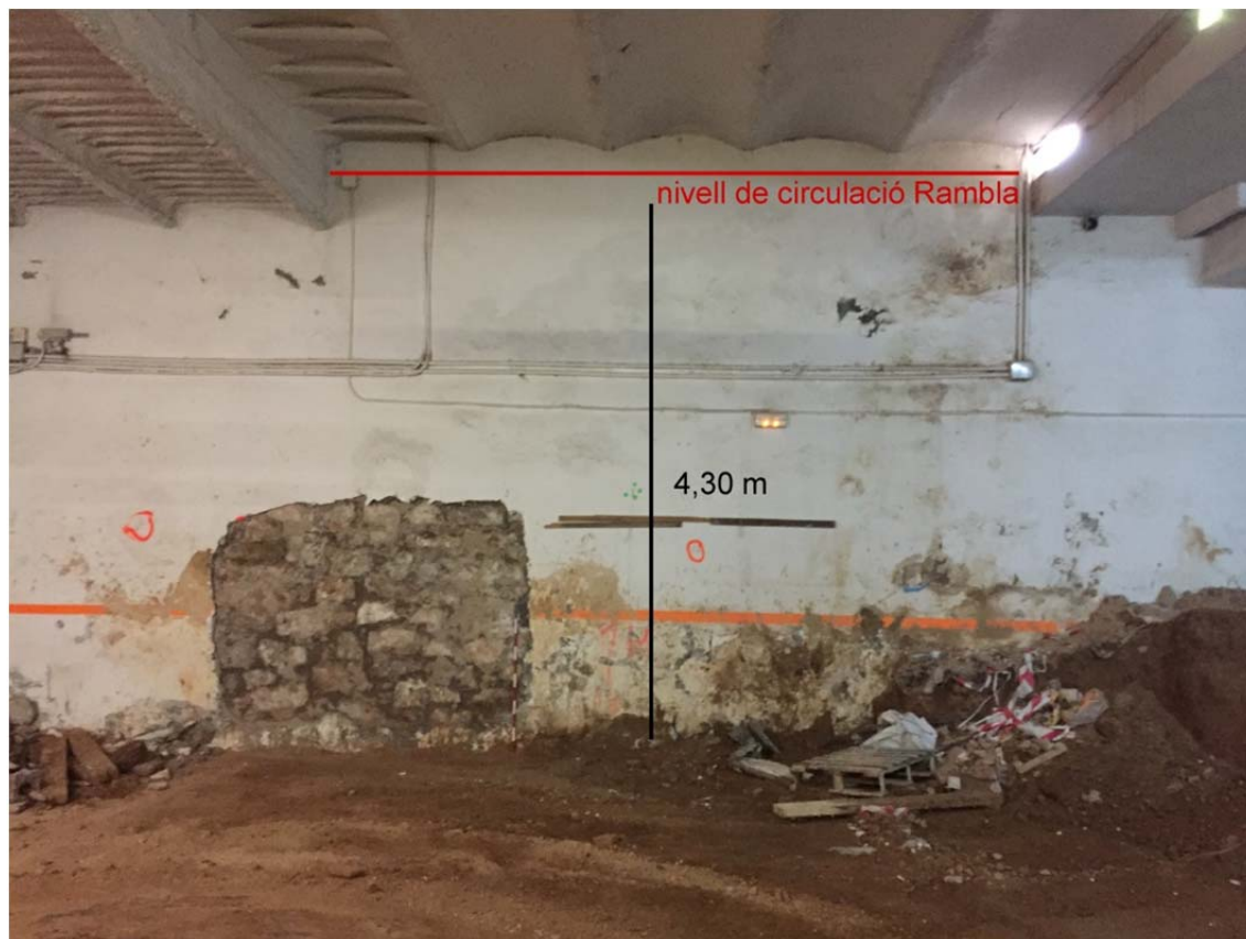
Figura 5. Fonaments de la façana de l'edifici (Rambla 124). A la dreta s'observa la rampa d'accés al garatge i a la dreta les escales d'accés al vestíbul de l'edifici.
