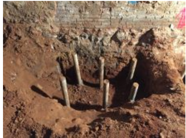
Foto 10. Excavació d'encepats
