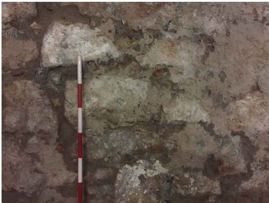
Figura 9. Detall del parament de la façana occidental
