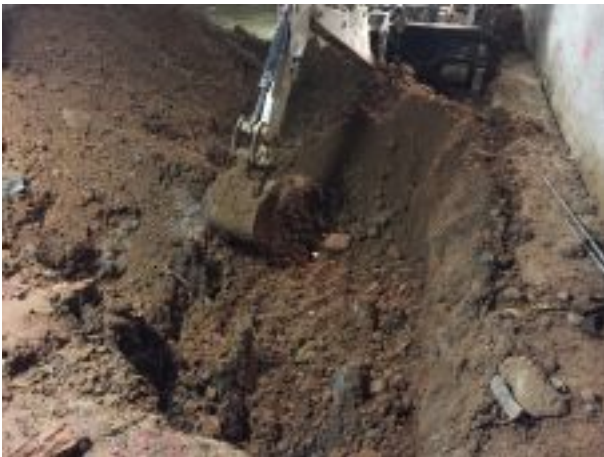
Foto 9. Tasques d'excavació d'encepats
