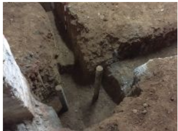
Foto 12. Excavació de riostres
