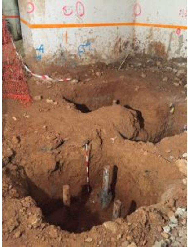
Foto 18. Vista general encepats. S'observa el paquet d'argiles
