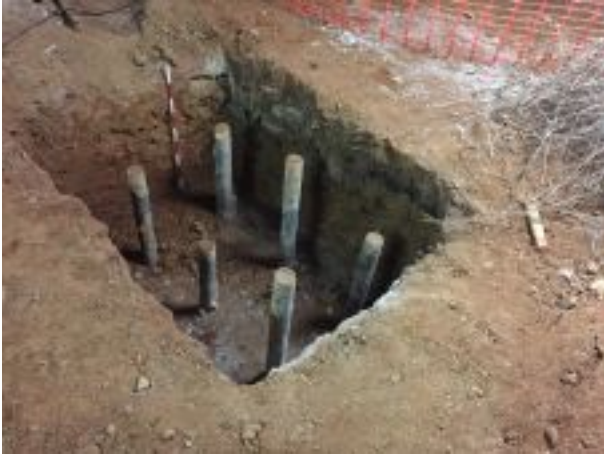
Foto 13. Excavació d'encepats. Estat final
