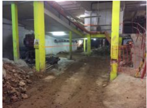
Foto 4. Soterrani. Estat inicial
