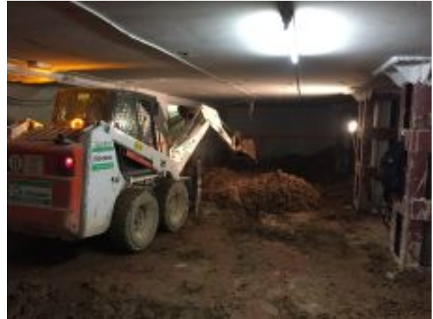
Foto 8. Inici tasques d'excavació
