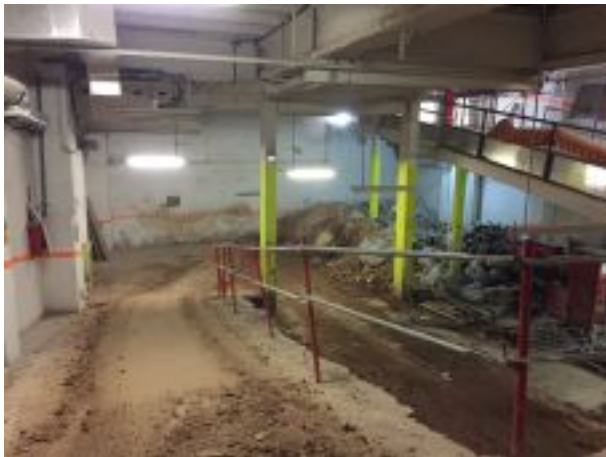
Foto 3. Rampa d'accés al soterrani.
