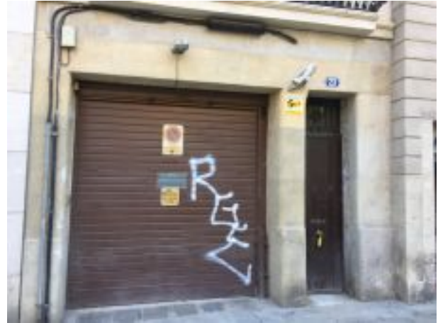
Foto 2. Façana posterior. Entrada al soterrani
